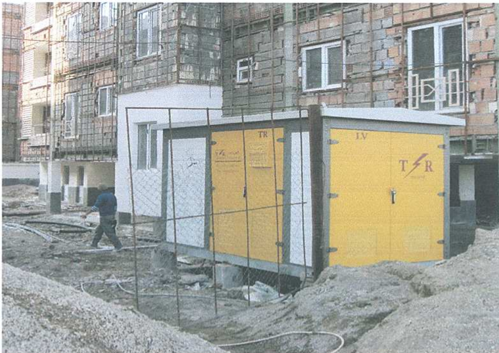
پروژه مسکن مهر گنبد (کارفرما بنیاد مسکن گلستان)
