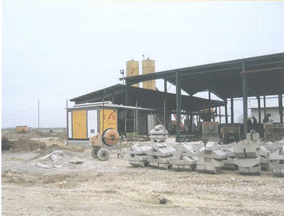
پروژه پست کمپکت کارگاه چپکرد جویبار (کارفرما: شرکت آب و خاک سمنان)
