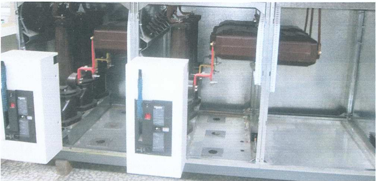
تابلو فشار متوسط چنج اوور با کنترلر اتوماتیک Sepam.B21 اشنایدر
